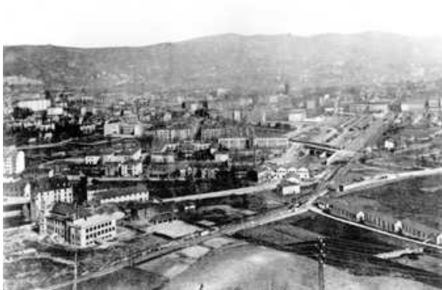
Imagen 1: Terrenos de Ametzola alrededor de 1925.
