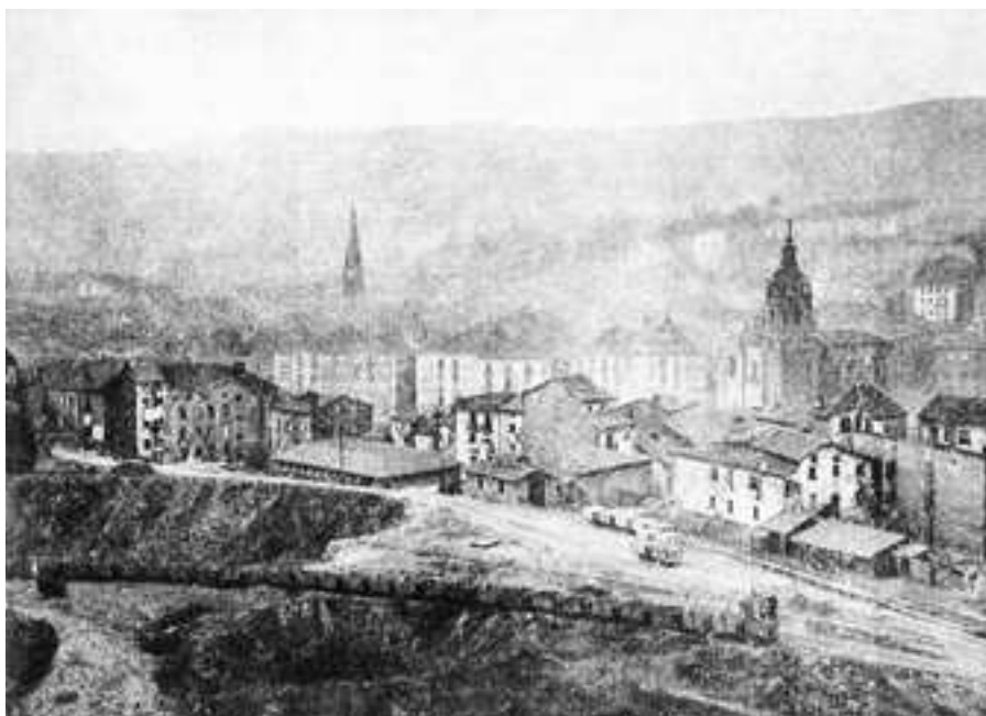
Imagen 5: Vista antigua de las minas “San Luis” y “Malaespera”.
