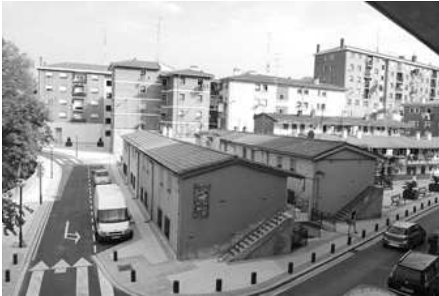
Imagen 16: Estos cuatro bloques son las primeras 48 casas construidas con el anagrama del Centro San José Obrero. Foto de 2009 después de la reforma del barrio.
