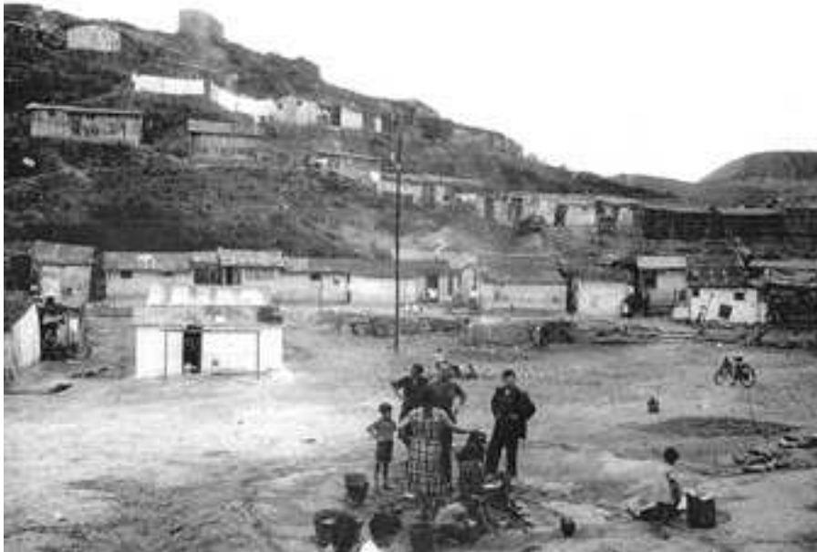
Imagen 6: Primera fuente y poste de luz. 1959.
