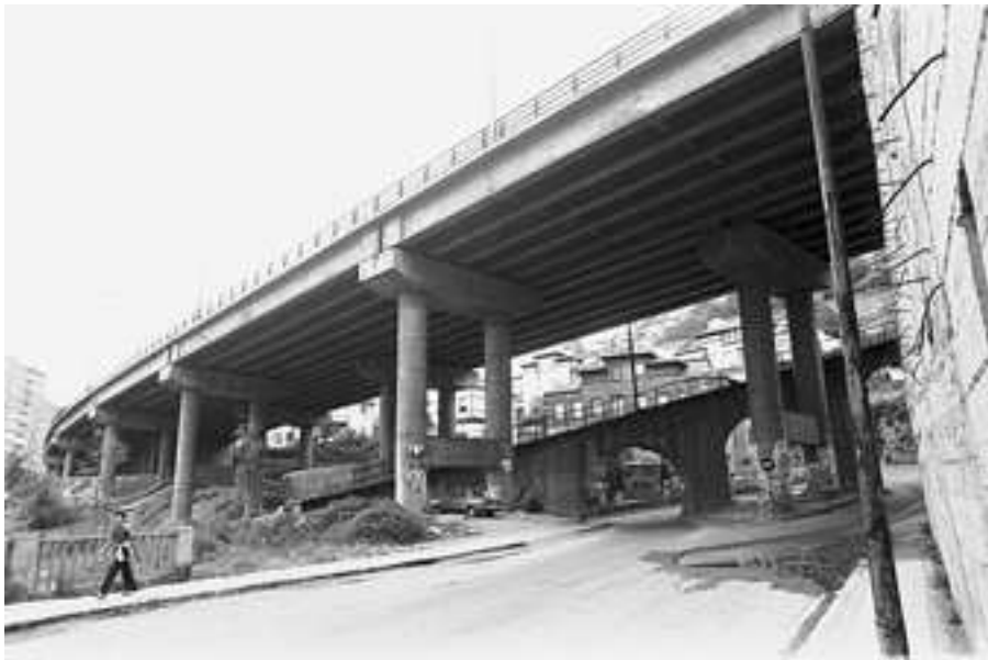
Imagen 9: Un espacio de desencuentro. Viaducto de la Solución Centro y debajo la vía del funicular de Artxanda. Al fondo las casas de Ciudad Jardín. Fuente: APJZ.
